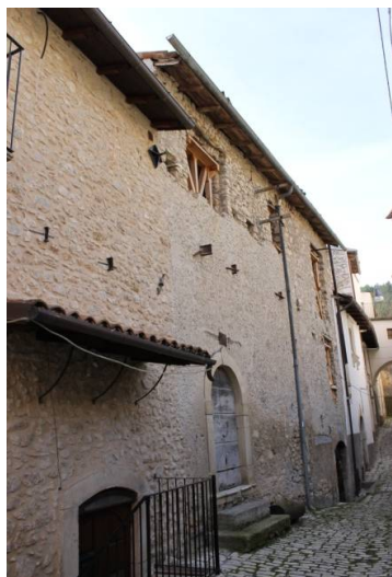
Edificio interessato da interventi di messa in sicurezza interna
