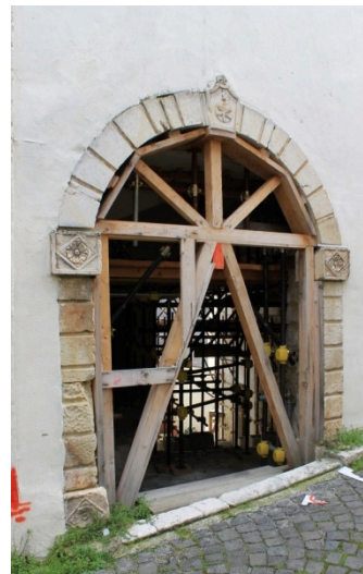
Centinatura di volta del sottopassaggio pedonale
